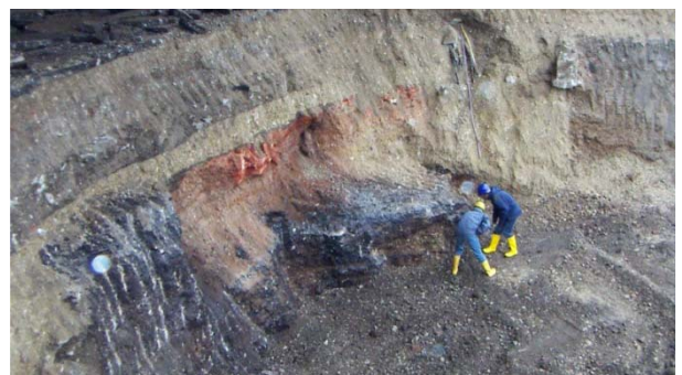
„Boden gutmachen“: Grundstücksaufbereitung durch die Bautochter omniCon im Münchner Arnulfpark
