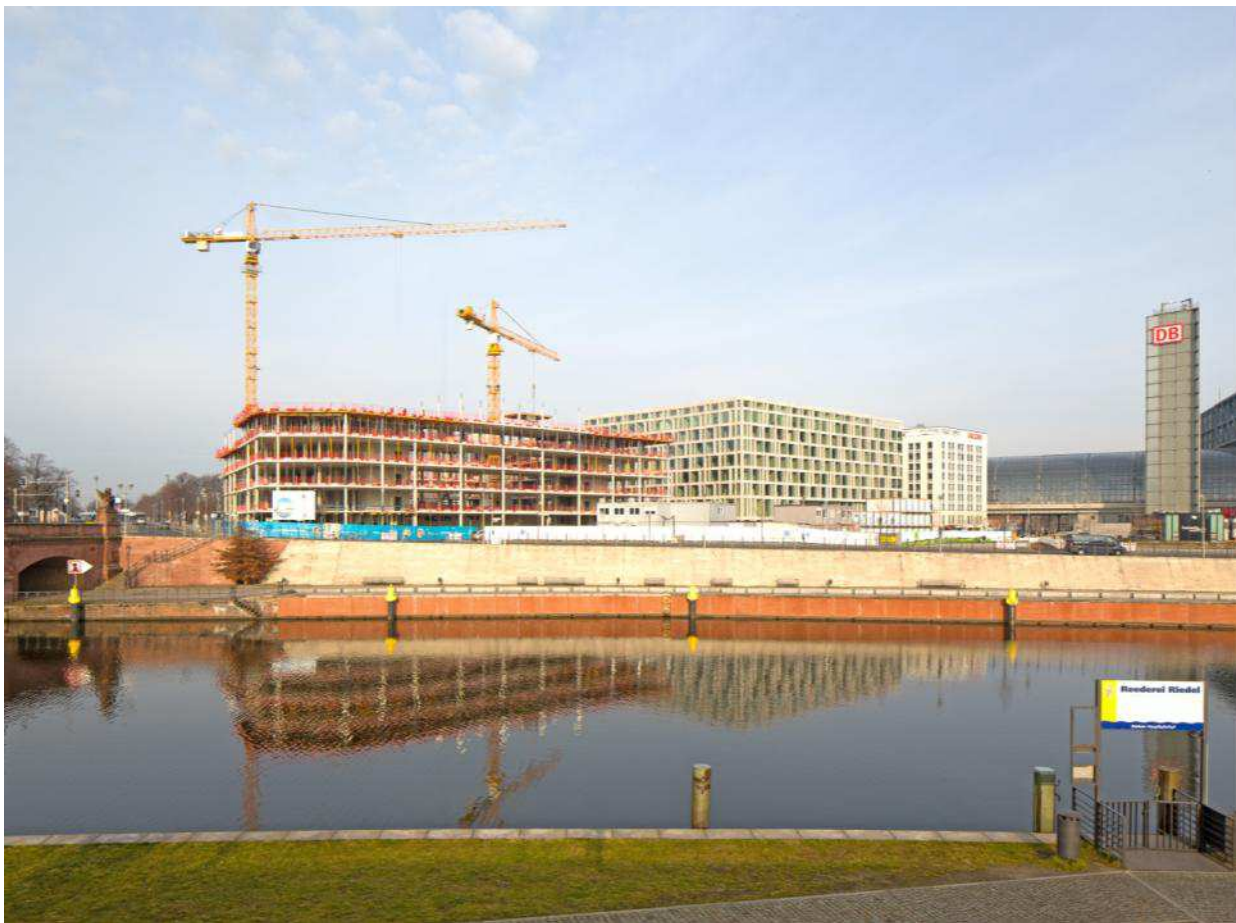
Baustelle des John F.-Kennedy Haus in der Berliner Europacity
