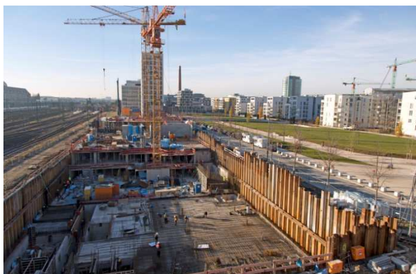
Baustelle des Kontorhaus im Münchner Arnulfpark
