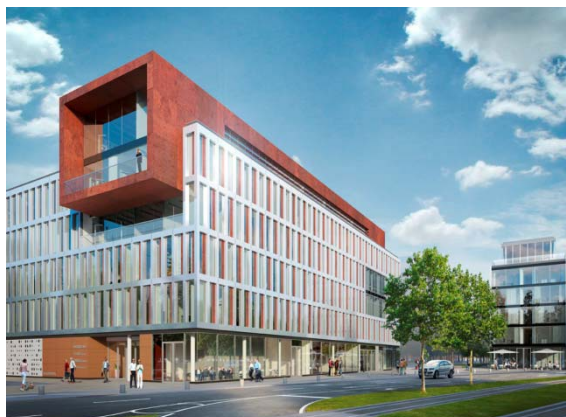
Bürogebäude Belmundo und Lavista in Düsseldorf: Baustart 2012
