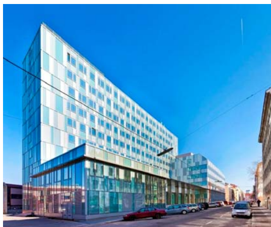
Bürogebäude Silbermöwe, Lände 3
