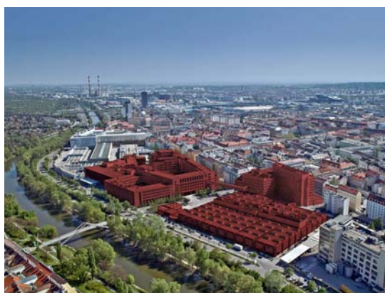
Quartier Lände 3 an der Erdberger Lände
